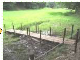
▲スロープと橋(製作途中)
