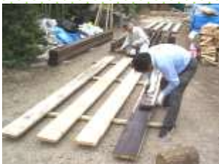
▲防腐剤の塗布
