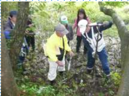
▲湧水の出る場所に塩ビ管を埋設する実習
